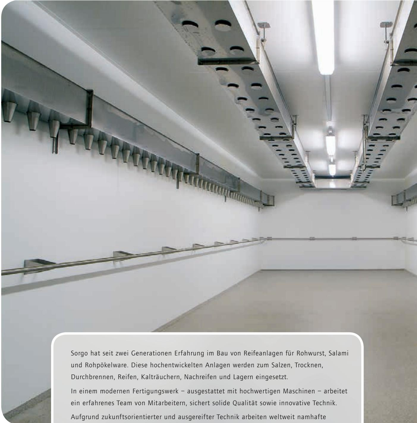
Sorgo hat seit zwei Generationen Erfahrung im Bau von Reifeanlagen für Rohwurst, Salami und Rohpökelware. Diese hochentwickelten Anlagen werden zum Salzen, Trocknen, Durchbrennen, Reifen, Kalträuchern, Nachreifen und Lagern eingesetzt.
